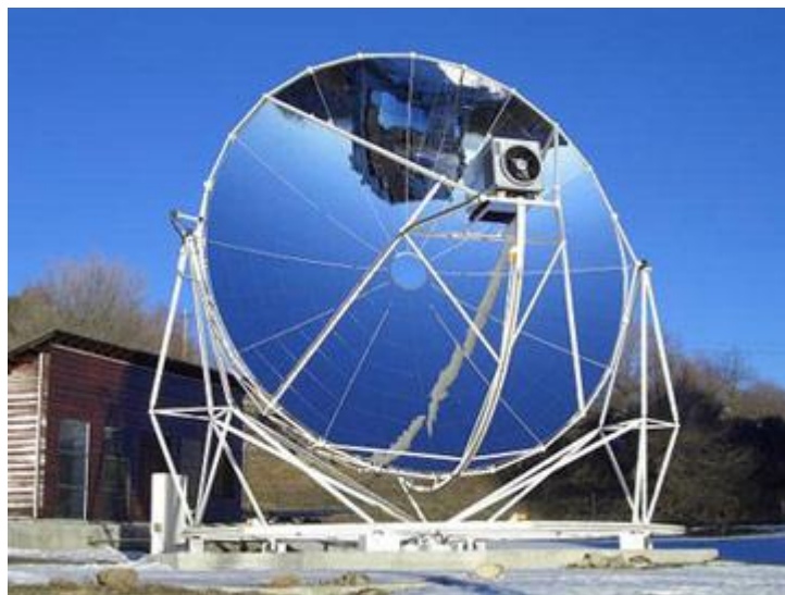
Figure 29 Module "parabole-Stirling" d'Odeillo
