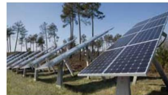
Figure 15 Suiveurs à rotation mono-axiale
