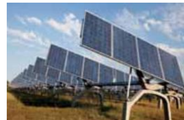
Figure 16 Suiveurs à rotation bi-axiale
