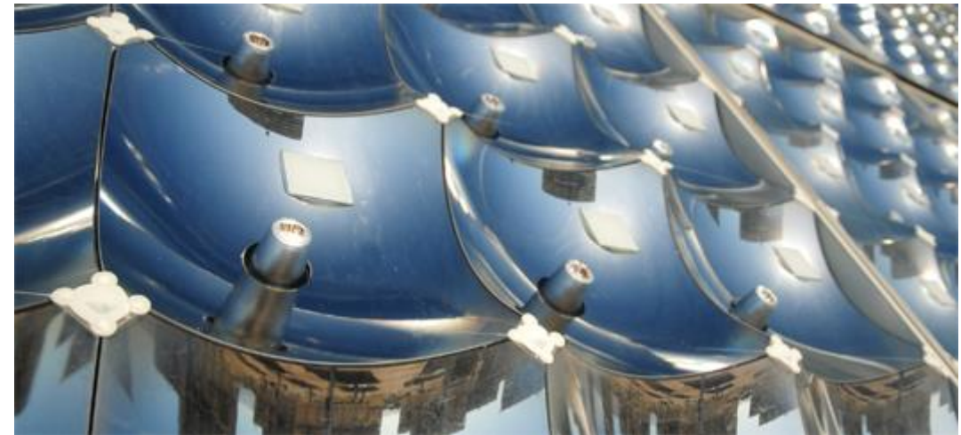
Figure 17 Panneau photovoltaïque concentré
