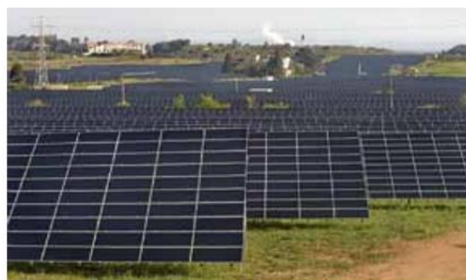
Figure 14 Exemples d'installations fixes au sol
