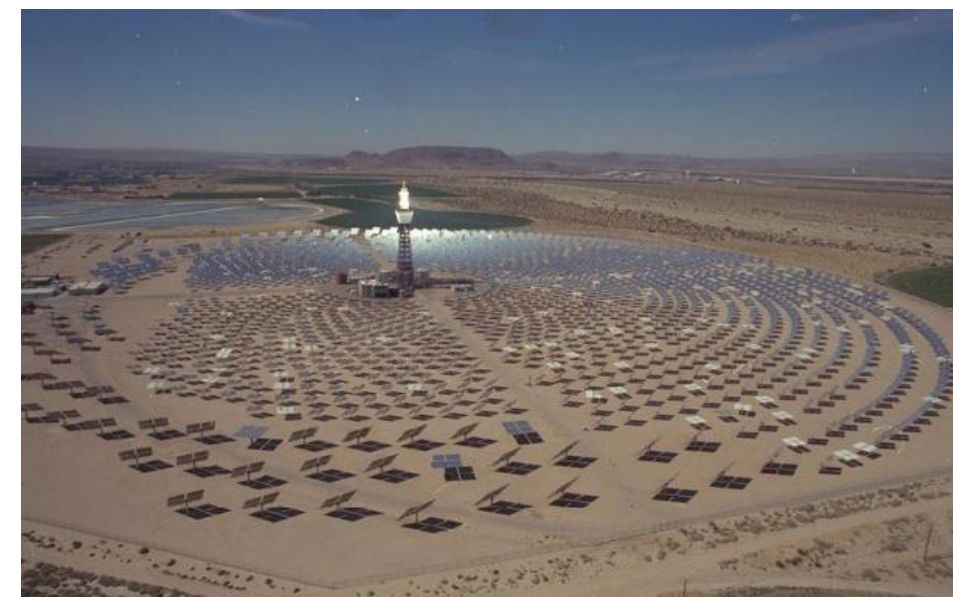
Figure 28 Centrale solaire à tour à caloporteur sels fondus
