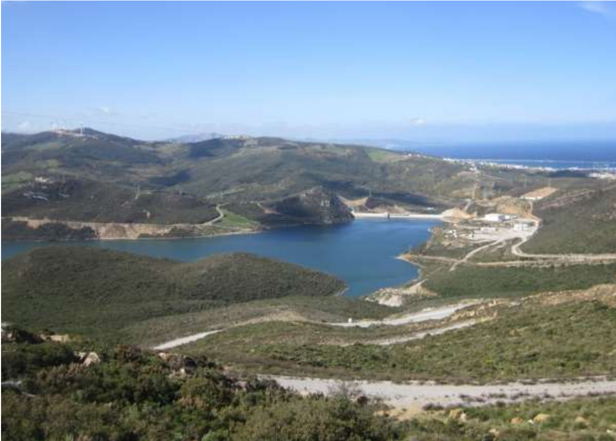
Figure 18-11 : Vue sur la retenue du barrage Oued Rmel
