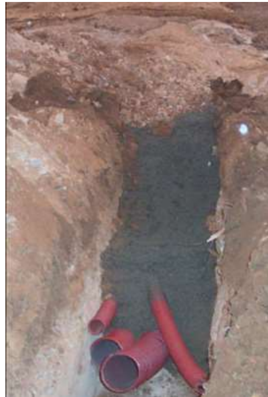
Figure 4-4 : Tranchées des câbles souterrains
