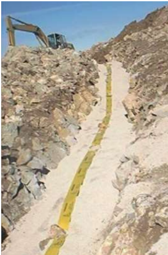
Figure 4-4 : Tranchées des câbles souterrains
