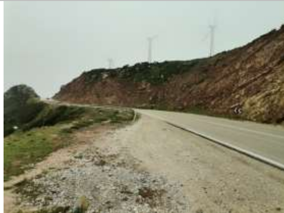
Figure 19-4 : La route provinciale 4703 traversant la crête principale
