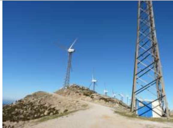
Figure 19-5 : Exemple de piste d'accès aux éoliennes existantes
