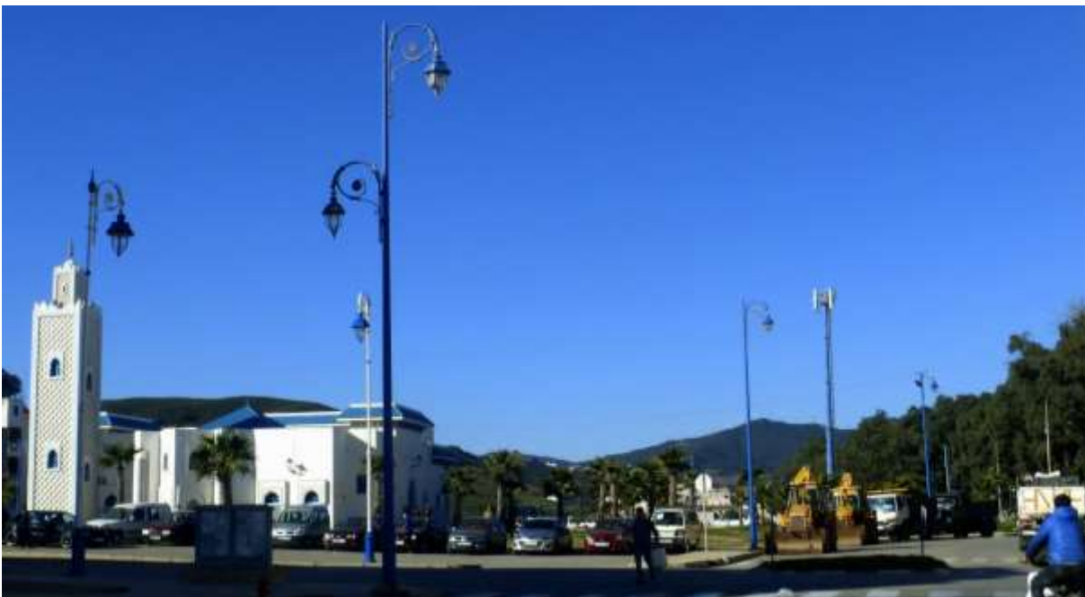
Figure 18-16 : Le parc éolien vue depuis le centre de la ville de Fnideq (Phénixa)
