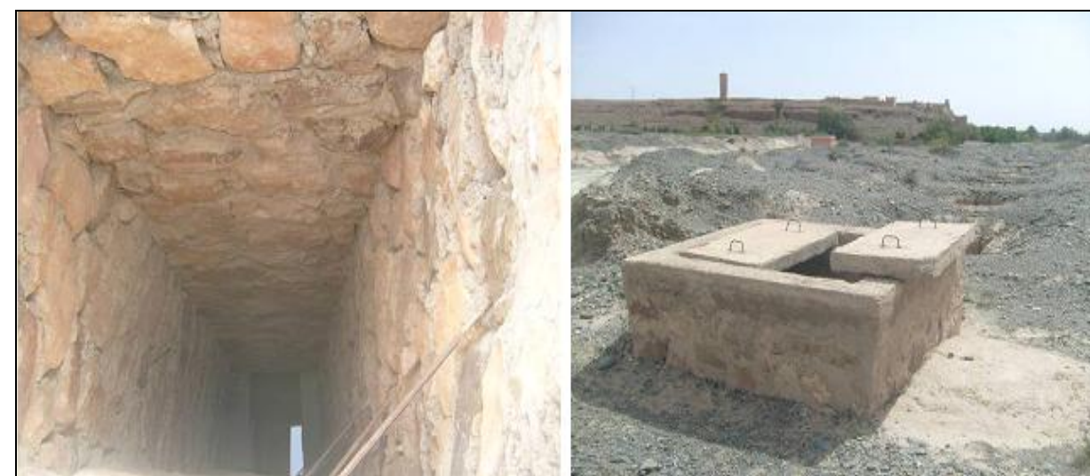
Photo 7 : Khettaras réhabilitée au niveau de Tiflité
