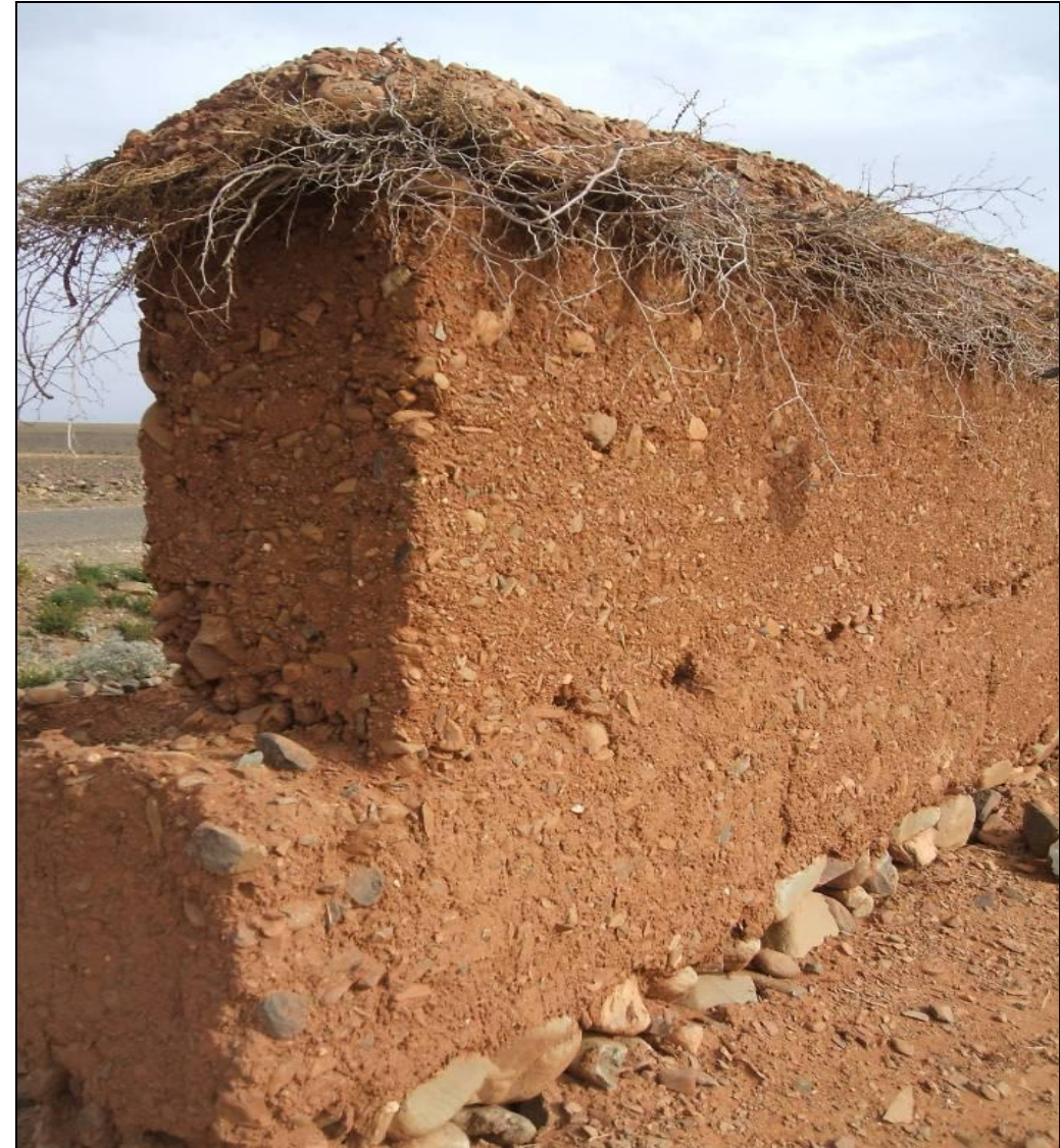
Photo 36 : Mur construit par la technique du pisé, avec la terre et les galets, avec un couronnement en branches de Jujubier fixées par la terre pour protéger le mur de l'effet érosif des pluies et pour qu'il soit infranchissable
