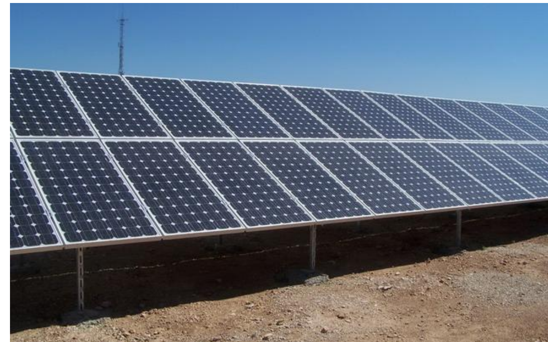
Figure 13 : Module utilisant des cellules monocristallines
