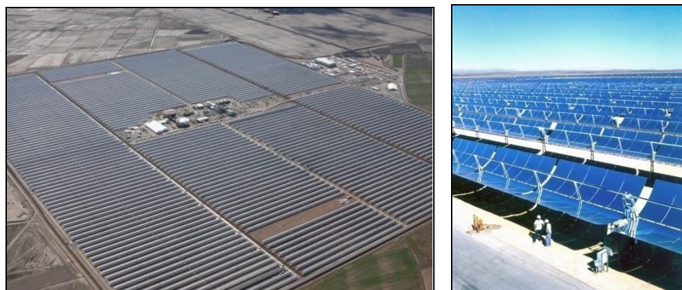
Figures 22 : Exemple de centrales à capteurs cylindro-paraboliques : Andasol 1 – Espagne (à gauche) et Solar Electric Generating Station VI – Etats-Unis (à droite)
