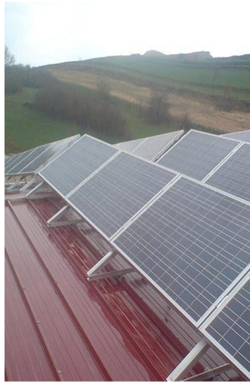
Figure 14 : Module utilisant des cellules polycristallines
