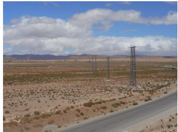
Figure 26: Lignes électriques existante à l'Ouest du projet
