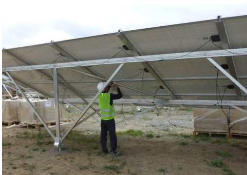
Figure 12: Câblage des panneaux
