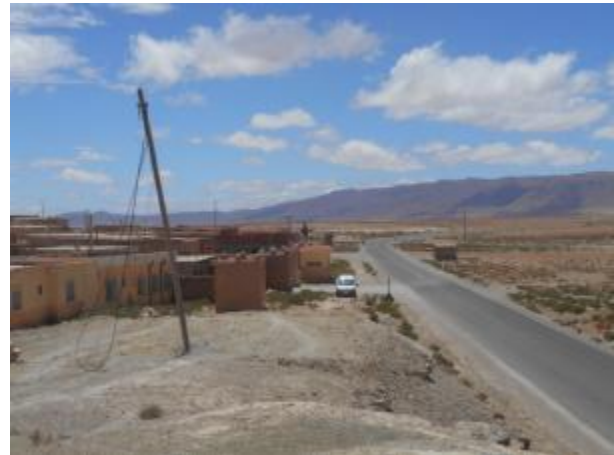
Photographie 5: vue de la route P5108 depuis Douar Enjil Ait Lahssen
