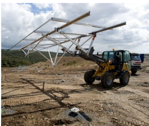
Figure 10: Exemple de montage des structures
