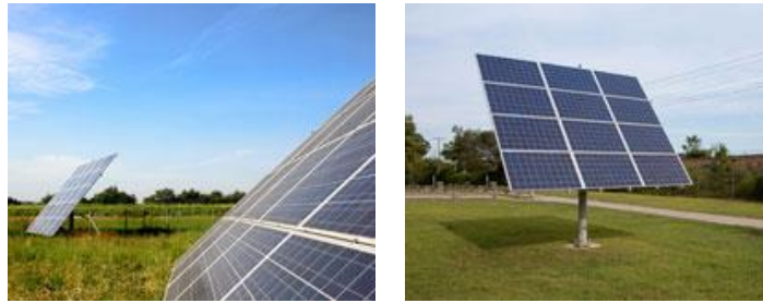
Figure 6: Panneaux photovoltaïques sur suiveur solaire
